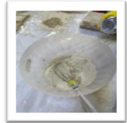
شكل رقم (13) مرحلة وضع بودرة الترا فلور بمقدار يتناسب مع مساحة العمل
