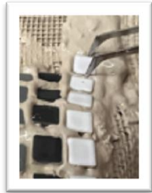
شكل رقم (19) تنسيق وحدات السترات من السيراميك على سطح الترا فلور قبل جفافه وهو في الحالة السائلة
