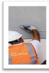
شكل رقم (6)، كيفية استخدام أدوات لفرد الخامة على الحائط
